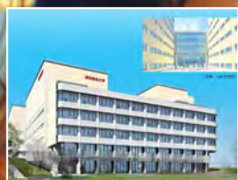
01. 新学部設立にむけ、南校舎に新棟を建設中
